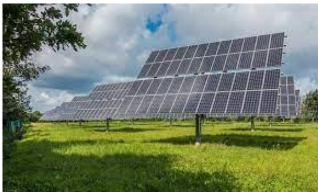
Fig. 3. Panouri fotovoltaice (convertesc energia solară în electricitate)
